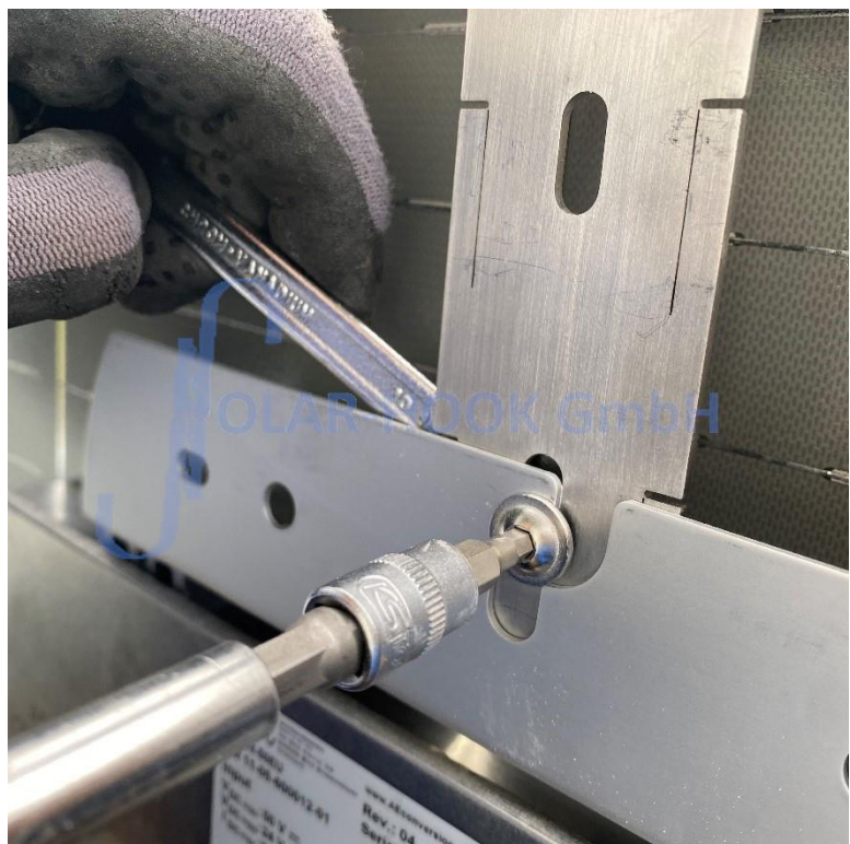
Abb. 6/Wechselrichter am SOLAR-HOOK Befestigungsbügel anschrauben
