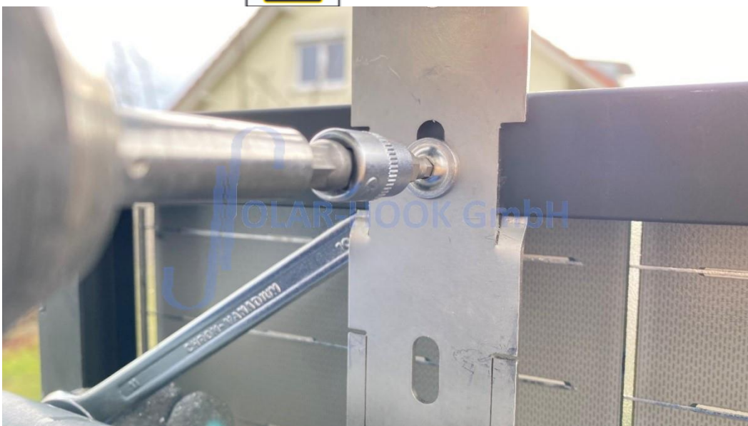
Abb. 16/Anziehen der kurzen Schrauben
